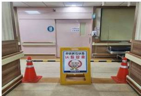
<공사구역 출입금지 안내판 설치 요청>
